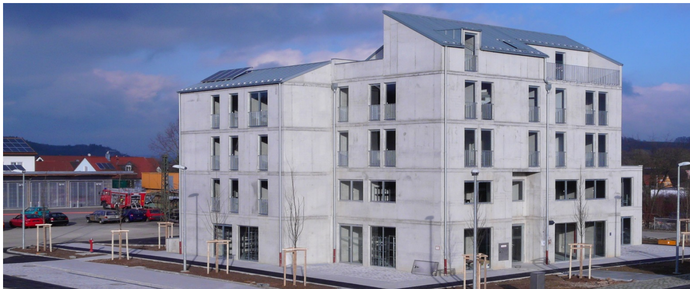
Südwestansicht (Foto © StBA R)
