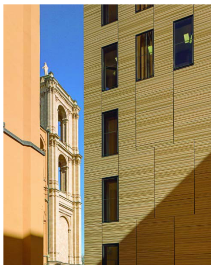
Südfassade (Foto: M. Heinrich, München)
