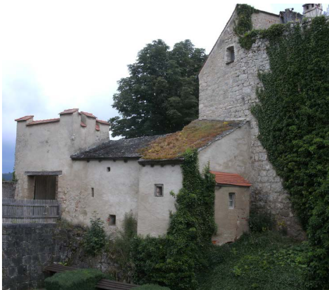
Torwarthaus; inn. Burgmauer alt; Foto: IB Siegmüller, Regensburg
