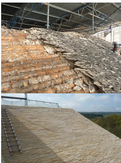
Legschieferdeckung alt/ neu Dach III u. IV
