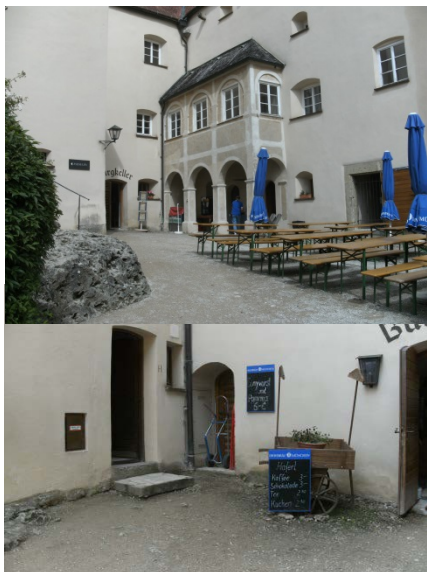
Zustand Innenhof vor Sanierung
