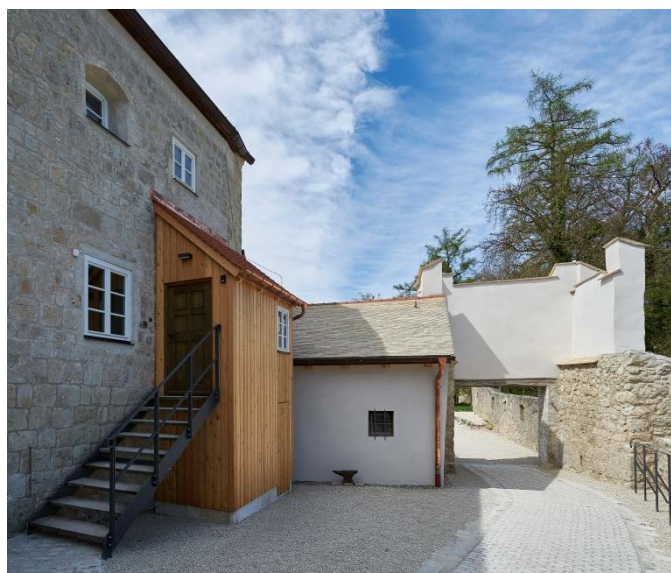
Zugang innerer Burghof neu, barrierefrei ; Foto: R. Sturm, Landshut
