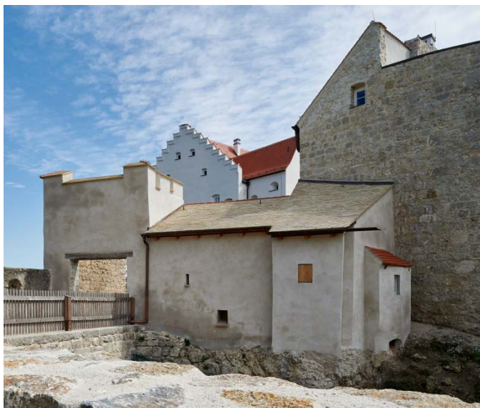
Torwarthaus, innere Burgmauer neu; Foto: R. Sturm, Landshut
