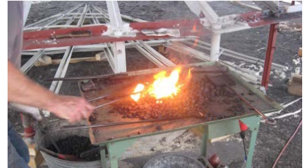
Feldschmiede im Schutzzelt; Herstellung von Nietverbindungen
