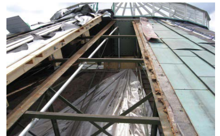
geöffnete Dachschalung; links: temporäres Schutzdach
