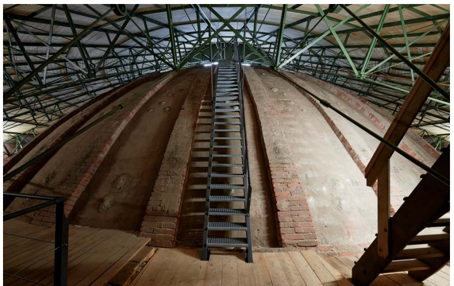
Innenansicht der Kuppel mit neuer Wartungstreppe (Foto: R. Sturm, Landshut)
