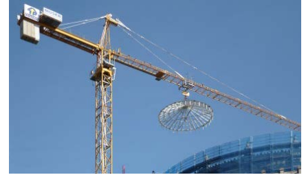
Abnehmen der Oberlichtkonstruktion
