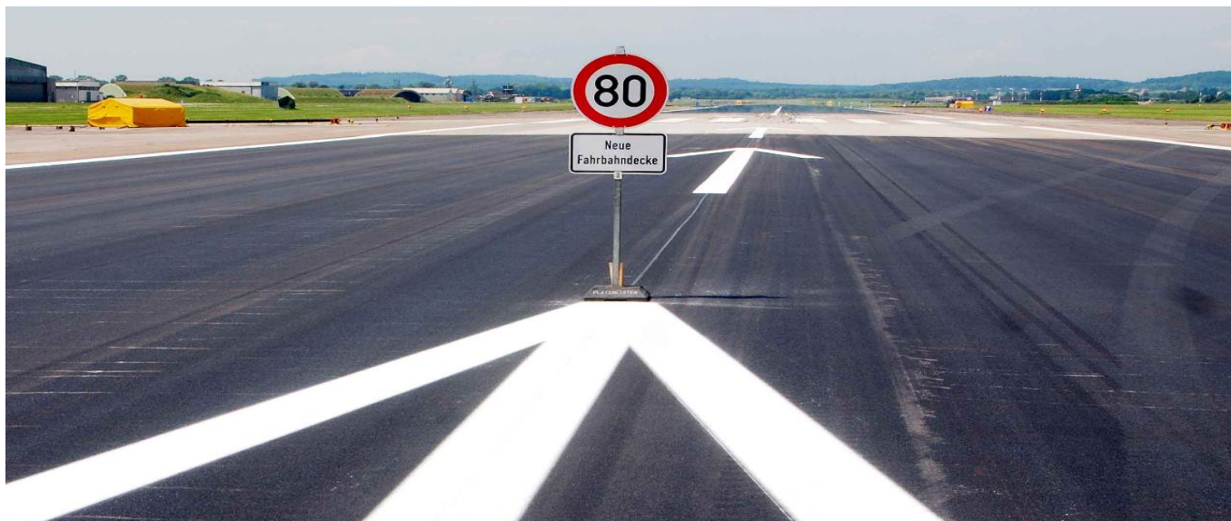
Fertiggestellte Startbahn mit Markierung (Foto: Jagdgeschwader 74, Neuburg / Donau)
