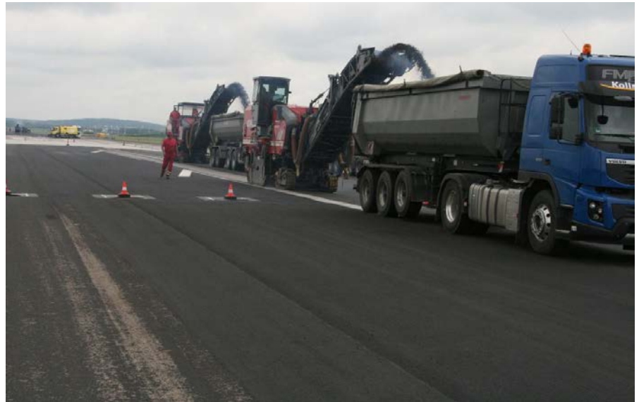
Abfräsen der schadhafte n Oberflächenschutzschicht (Foto: StBA IN, Ingolstadt)
