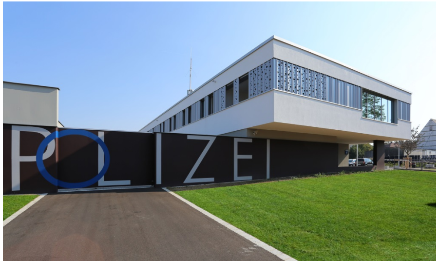
Ansicht von Südwesten mit Einfahrt Polizeihof (© StBA Amberg-Sulzbach)
