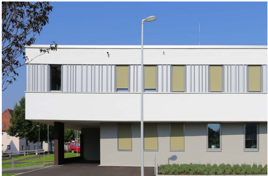
Ansicht von Osten (© StBA Amberg-Sulzbach)
