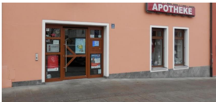
Barrierefreie Eingänge, Mitterteich © Regine Harrer, Regierung der Oberpfalz
