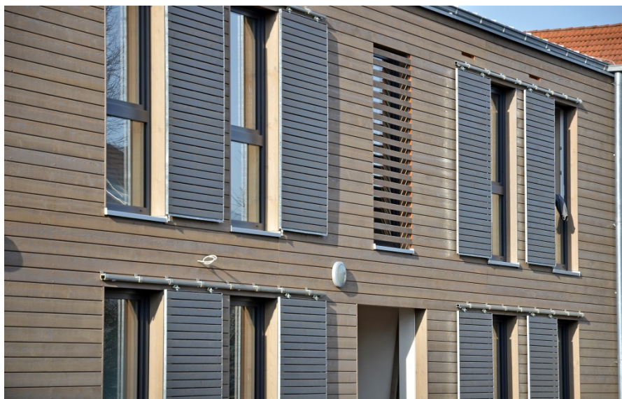
Ansicht der Ostfassade (© StBA AN)
